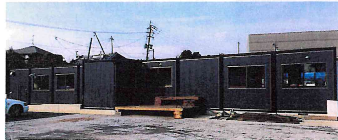
▲新拠点となる建設中の施設
