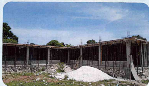
屋根の工事が完了しました！
