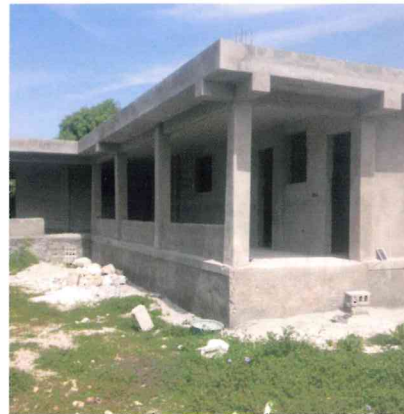
職業訓練校 屋根の補強工事が完了しました
